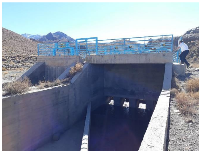
شکل ۲۲: تأسیسات انحراف آب برای حوضچه‌های تغذیه مصنوعی بر روی رودخانه هفت کوسک
