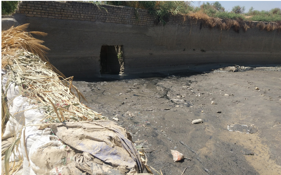
بند طالب‌آباد بر روی سرخه حصار و ورودی آب به نهر طالب‌آباد
