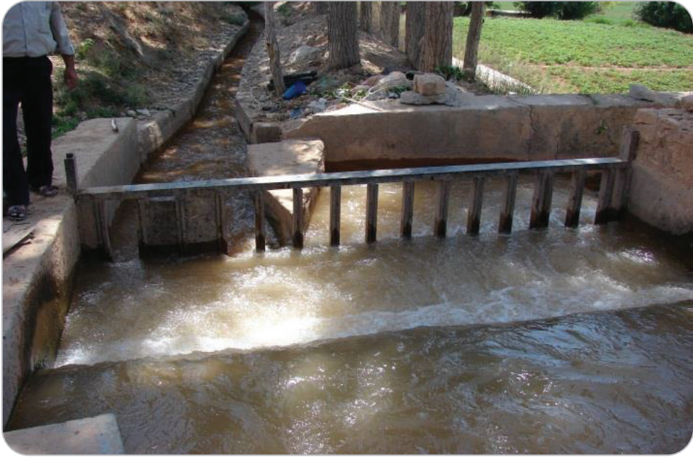
شکل ۱۳: مقسم فلزی در محل انشعاب کانال درجه ۲ از کانال درجه ۱ (عکس از رجب پور و مجبی، ۱۳۹۴)
