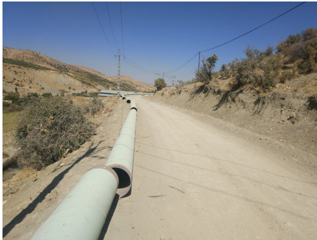
شکل ۳۳ جاده دسترسی و لوله گذاری برای پروژه ۳۰۰ هکتاری اسفیان و تله زری
