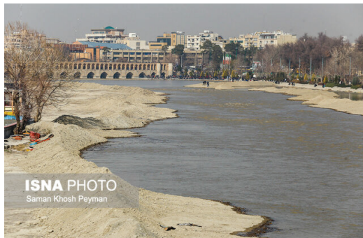
شکل ۵۵) محدود کردن پهنای رودخانه با عمیق کردن میانه و ایجاد خاکریز در طرفین آن
