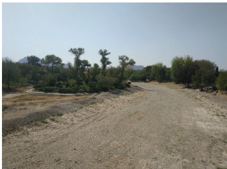
شکل ۵۵) محدود کردن پهنای رودخانه با عمیق کردن میانه و ایجاد خاکریز در طرفین آن
